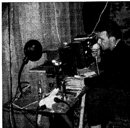
Het Twentse velddagstation PAoHDG/P werkte op 2 m. Achter de mike PAoHWO. Geheel rechts de 2 m zender; hiernaast de achterzet-ontvanger met hierboven de converter. Het kastje links bevat de antenne-draai-inrichting
